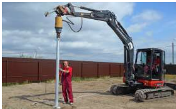
б) установка гидробуром
