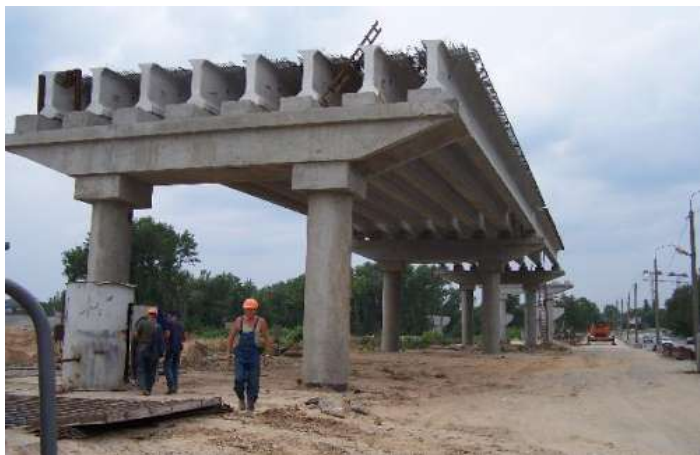
Рис. 4 – Мостовые опоры, выполненные из СУБа
