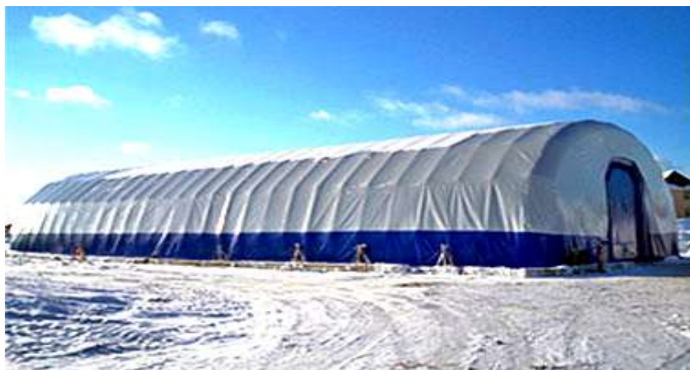
Рис. 2 – Комбинированное воздухоопорное сооружение, усиленное металлическими арками. 2008 г. Ямал
