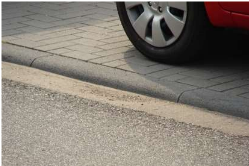
Сопряжение проезжей части дороги и парковки бордюрным камнем
