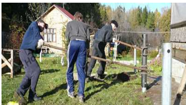
а) установка свай вручную
