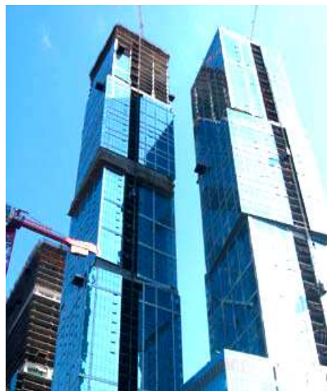
Рис. 2 – Комплексы «Город столиц» и «Федерация» в процессе строительства
