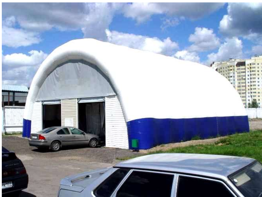
Рис. 1 – Воздухонесомое сооружение мойки автомобилей. 2012 г. Санкт-Петербург
