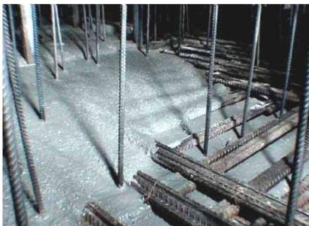
Рис. 1 – Каркас башен ММДЦ «Москва-Сити» в процессе строительства
