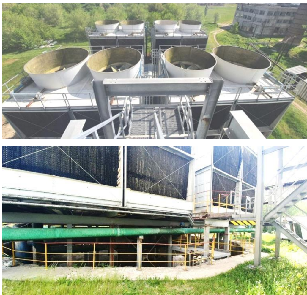
Рис. 3. Общий вид установленных восьми секций, сблокированных попарно в четыре блока
