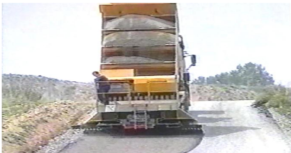
Рис. 1. Применение битумощебнераспределителя на дорожных покрытиях со значительным уклоном
