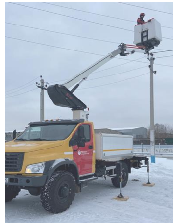
Рис. 5. Обучение управлению АГПИ для выполнения работ методом «в изоляции»
