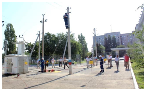
Рис. 2. Демонстрация работ под напряжением при открытии учебного центра в КТИ (филиале) ВолгГТУ
