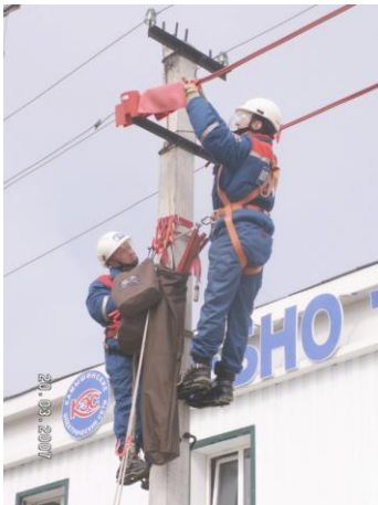
Рис. 3. Работы под напряжением методом «в контакте»
