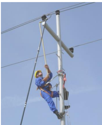
Рис. 4. Установка разрядника под напряжением методом «на расстоянии»
