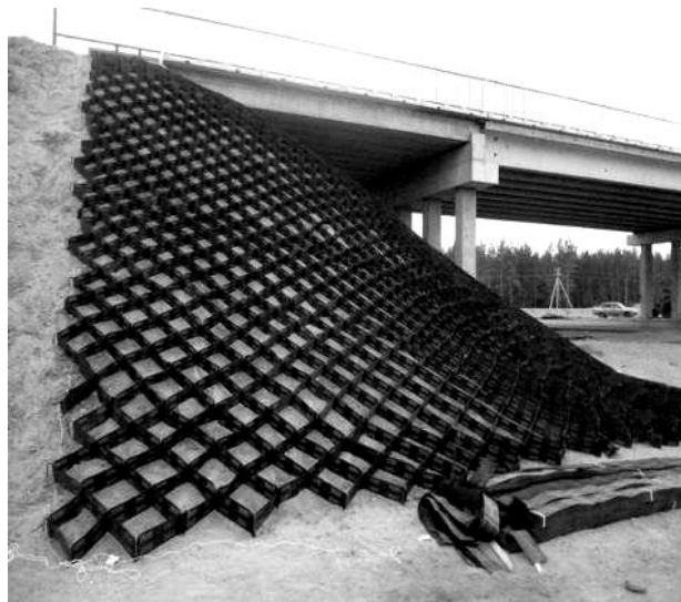
Рис. 1. Использование георешётки в ландшафтном строительстве
