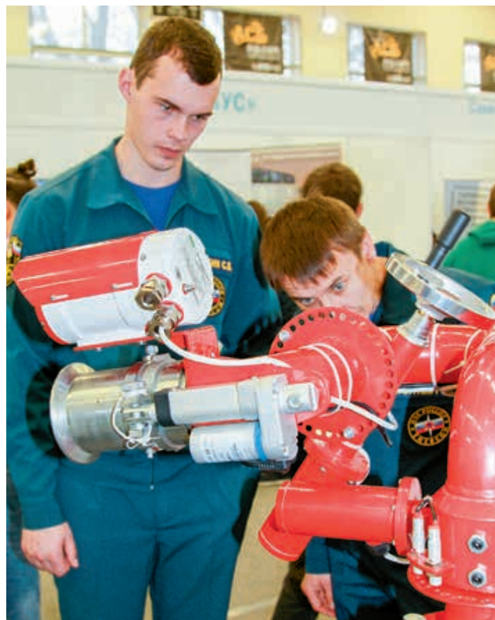
Программно-логический контроллер ООО «СИНКРОСС» обеспечивает работу системы пожаротушения на космодроме «Восточный»
