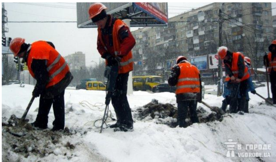
Рисунок 1 – Производство земляных работ в зимнее время
