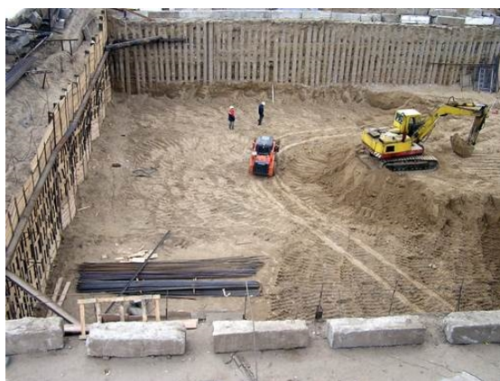
Рис. 1 – Ограждение стенок котлована буронабивными сваями с анкерным креплением (а), металлическим шпунтом (б)
