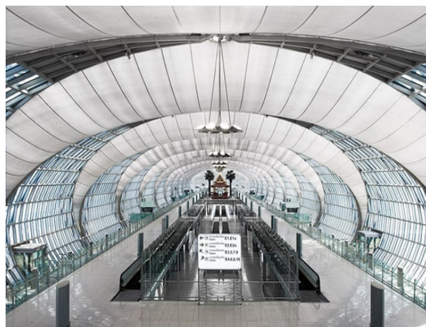
Рис. 7. Международный аэропорт в Бангкоке. Конструкции покрытия
