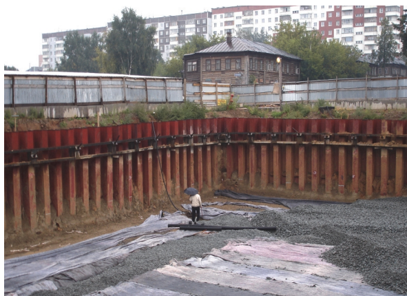
Рис. 1 – Ограждение стенок котлована буронабивными сваями с анкерным креплением (а), металлическим шпунтом (б)
