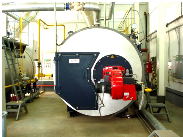
Рис. 4. Обследование котельной ОАО «Хенкель-рус» (филиал в г. Энгельсе Саратовской области) [Цымбалов А.А., 2011]
