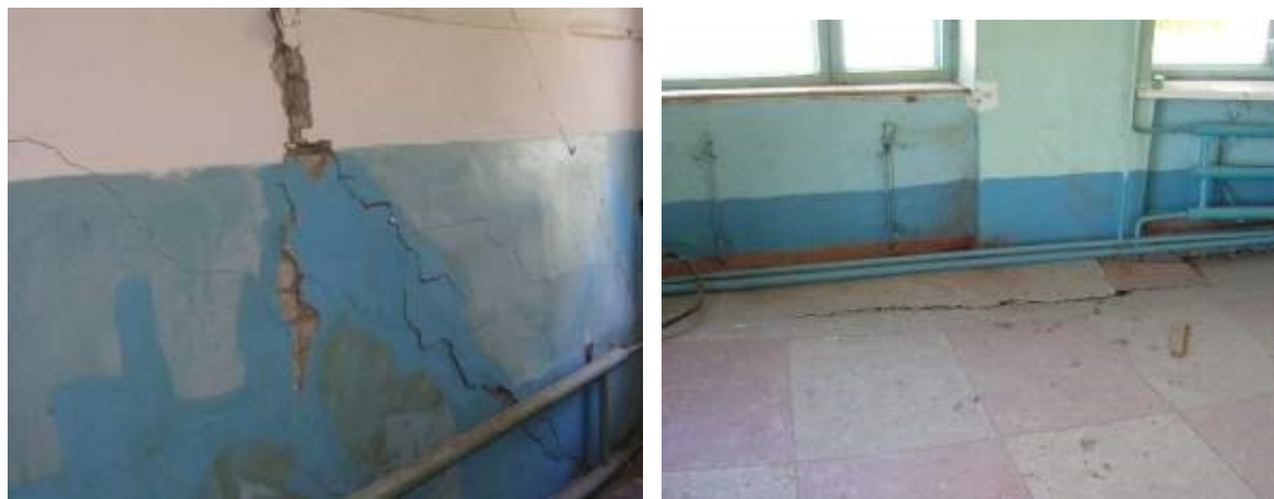
Рис. 3 – Деформации конструкций. а – внутренней стены; б – полов
