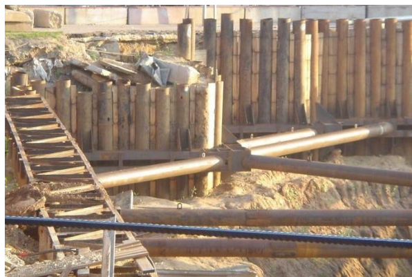
Рис. 2 – Ограждение стенок котлована: трубами (а), цементацией (б)
