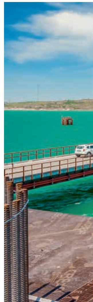
Сделано на века: выпускник специальности «строительство железных дорог, мостов и транспортных тоннелей» Артемий Кокодеев на строительстве Керченского моста
