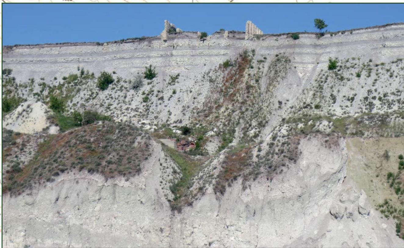
Разрушенное оползнем промышленное строение севернее села Нижняя Банновка. Оползневые процессы активизированы поднятием уровня воды после создания водохранилища
