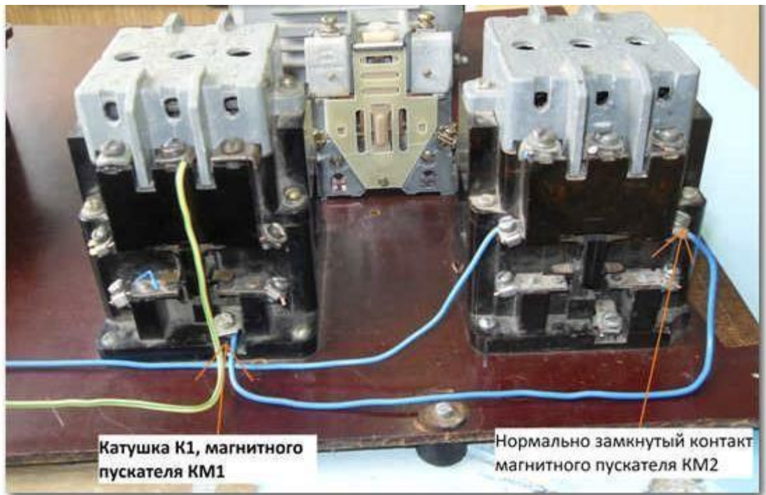
Рисунок 25 – Сборка соединения блок-контакта магнитного пускателя с катушкой магнитного пускателя на монтажной схеме
