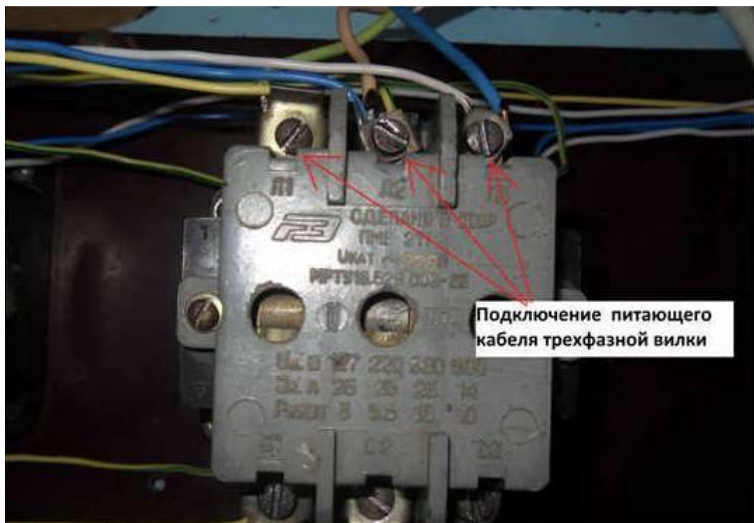
Рисунок 89 – Подключение трехфазной вилки к магнитному пускателью на фазы «А», «В», «С» сети на стенде
