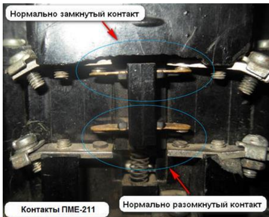
Рисунок 7 – Виды контактов магнитного пускателя
