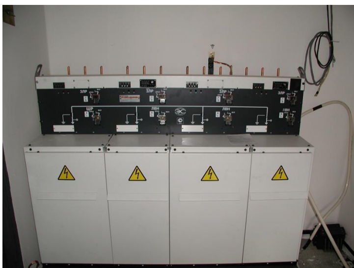
Рисунок 8.1- Комплектное распределительное устройство (КРУ) типа RM6 на 4 присоединения.
